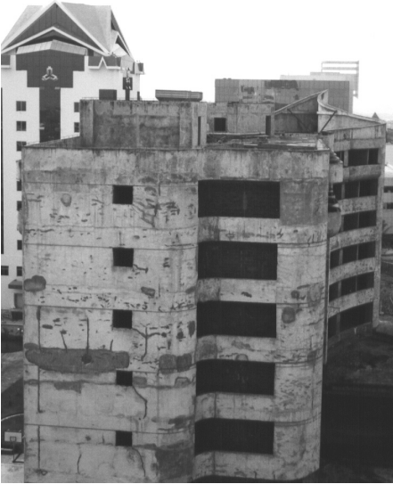
Do hậu quả dây chuyền của cuộc khủng hoảng kinh tế Thái Lan 1998 nhiều cao ốc đang xây bị bỏ dở dang và trở thành hoang phế
