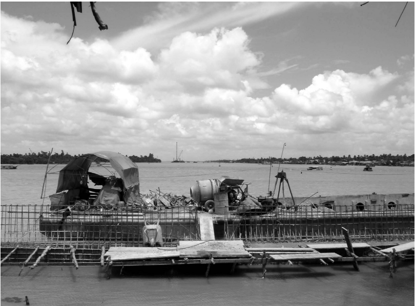
Cảnh xây “Kè” lấn sông để có thêm đất trên sông Hậu, thế lực nào cho phép và ai có phương tiện sắt thép xi măng để thực hiện các công trình đại trà ấy?
