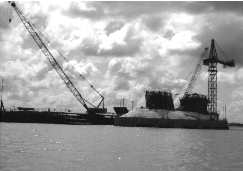
Dự án cầu Cần Thơ với gói thầu II Nhật Bản là phần công trình xây cầu chính dài 2.75 km với 4 đường xe chạy với độ thoáng cao 39 m
