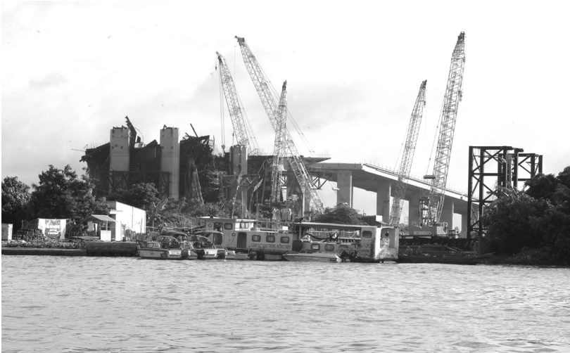
26-09-2007_ Cầu dẫn phía Vĩnh Long – Gói thầu I Việt Nam, Công trình cầu Cần Thơ bị sập, hình chụp từ sông Hậu sáng ngày hôm sau (H. Anh Chương)
