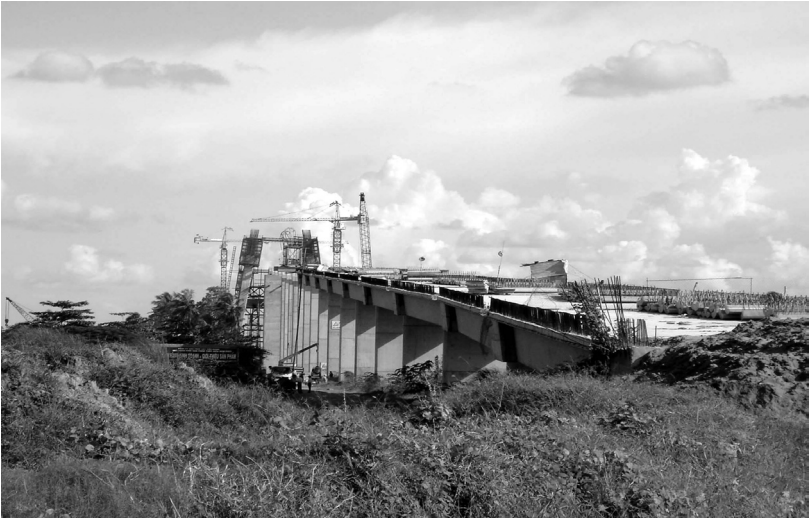
Công trình xây cây cầu Rạch Miếu nối hai tỉnh Tiền Giang Bến Tre, khởi công 2002 dự trù hoàn tất 06-2006 nhưng vẫn dở dang với bao nhiêu sự cố xảy ra và đang chờ sự tiếp tay kỹ thuật của các công ty xây cất ngoại quốc
