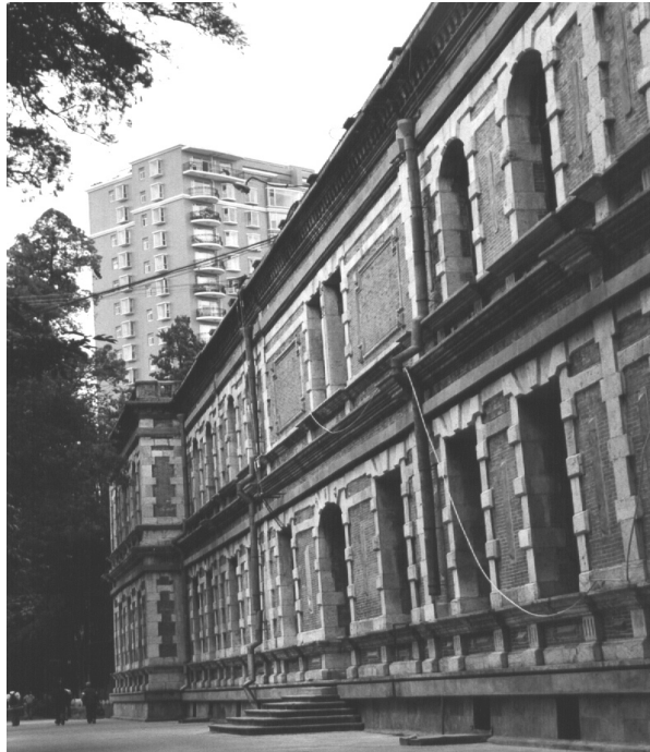
Kiến trúc cổ kính của Đại Học Vân Nam đang từng phần được san bằng để thay thế bằng những công trình kiến trúc hiện đại
