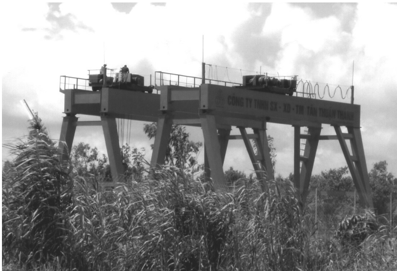
Trang thiết bị làm Đường Dẫn tới cầu Cần Thơ
